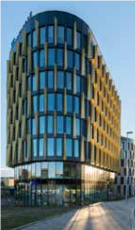
Kotelna Park II, Praha, Česká republika Certifikace BREEAM „Very good“
